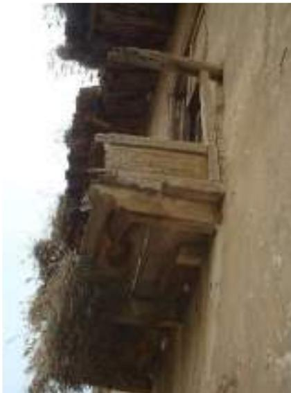
Baranda de madera y Rejas metálicas Protector de Ventana, Botaguas y molduras de ladrillo, marco de Revoque de Cal y Cemento sobre ventana
